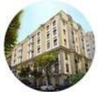
Après surélévation et rénovation
