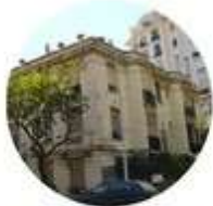
Avant surélévation et rénovation
